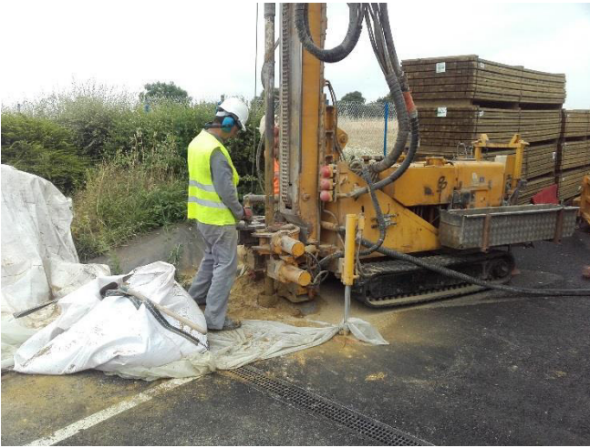
Forage du piézomètre Pz3
